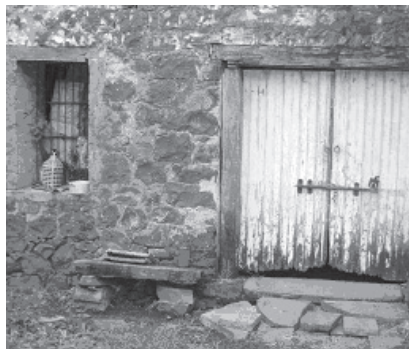
Entrada do porão (cantina) da casa, onde eram fabricados os vinhos da família.
