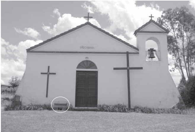
Atual Igreja da Comunidade São Gabriel – Linha 40. Veja abaixo, a pedra que está em destaque.
